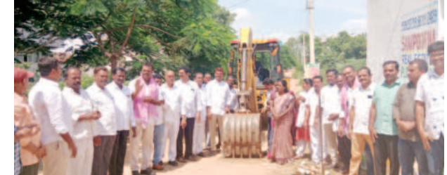
పోచారం మున్సిపల్ నారపల్లిలో దాతల సహాయంతో నిర్మిస్తున్న భూగర్భవైదీనే నిర్మాణ పనులకు భూమిపూజ చేసిన చైర్మన్ కొండల్ రెడ్డి.
